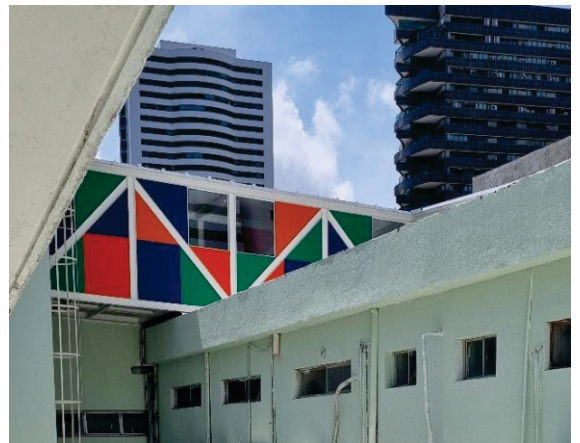
Antes e depois da passarela
